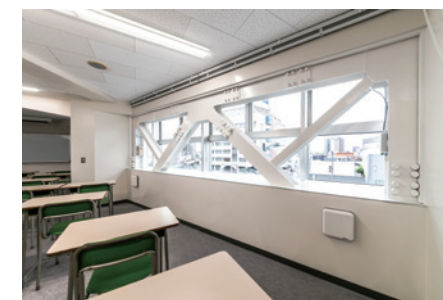
6階耐震工事部分
